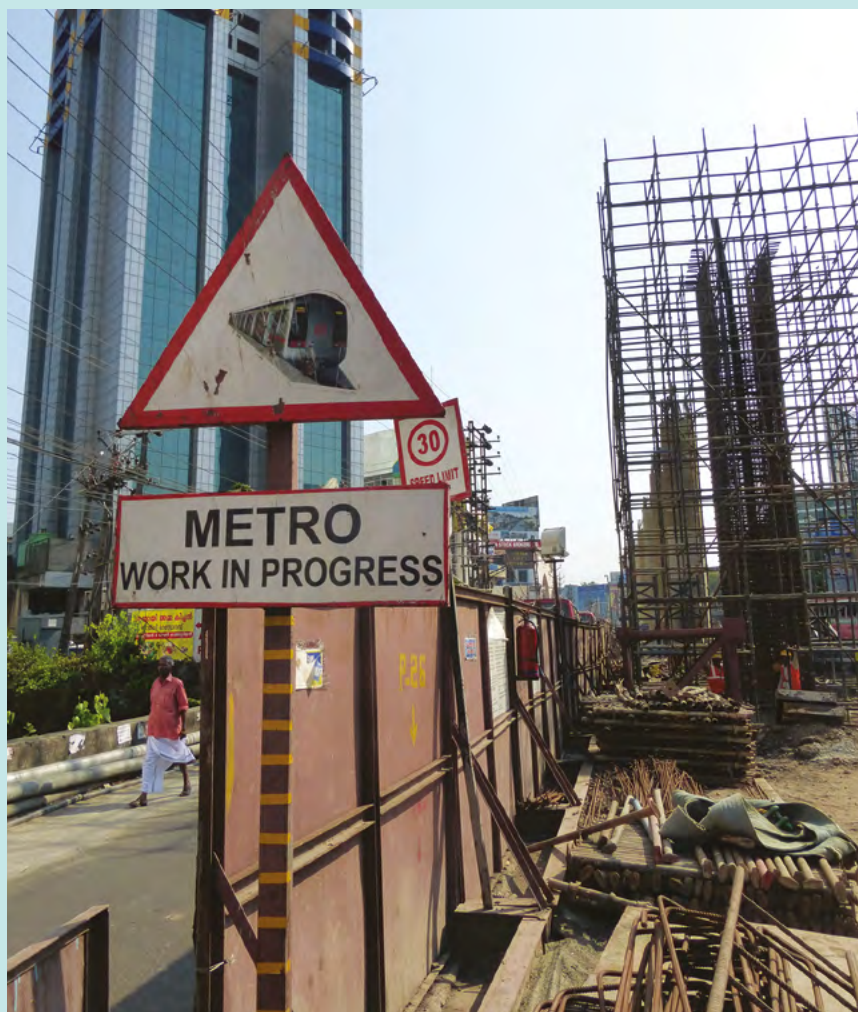
Figura 21 : Construcción del metro de Kochi, estado del Kerala
