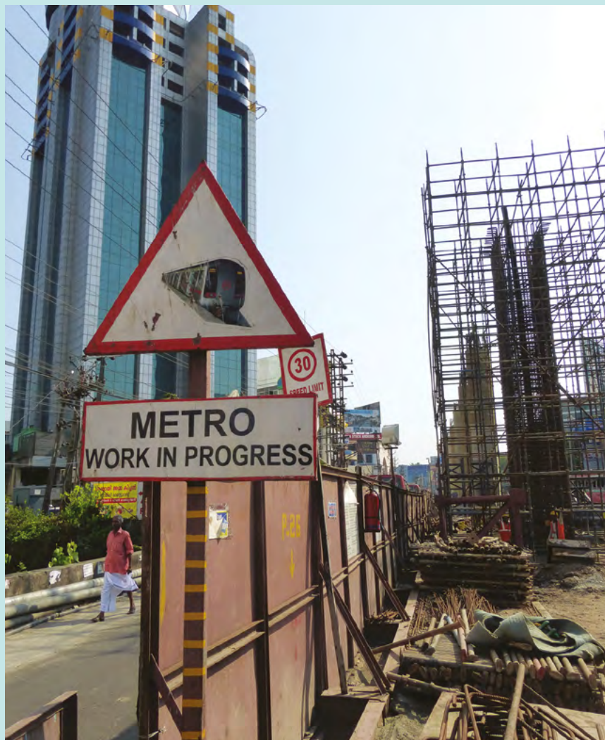
Figure 22 : construction du métro de Kochi, Etat du Kerala
