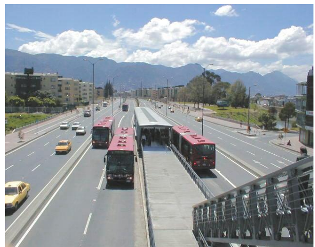
Bus articulés dans le site propre bus à deux voies par sens au droit d'une station accessible par une passerelle
