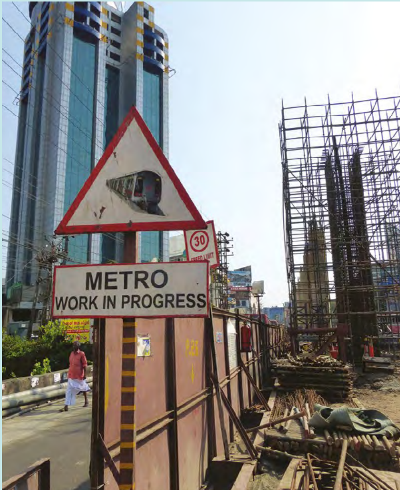
Figura 21: construção do metrô de Kochi, Estado do Kerala
